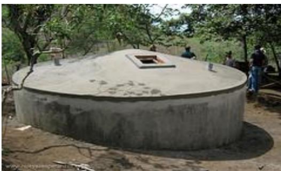
Tanque semienterrado de ferrocemento
