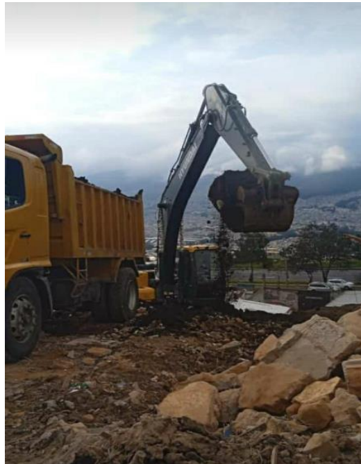
Figura 3.12. Excavadora Hyundai y Volqueta Hino GH realizando trabajo de derrocamiento de una vivienda.
