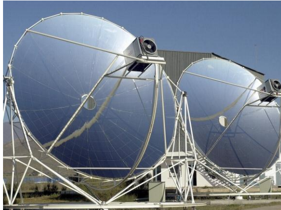
FIGURA 15. LA FOTO CORRESPONDE A DOS MÓDULOS EURODISH COMPUESTOS POR UN CONCENTRADOR DE DISEÑO ESPAÑOL Y UN MOTOR SOLO V161.
