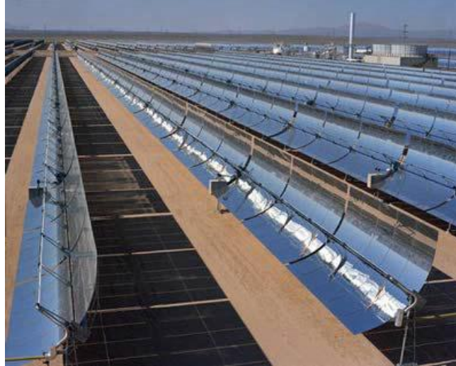
FIGURA 13. CAMPO DE ESPEJOS COLECTORES PARABÓLICOS DE CANAL.
