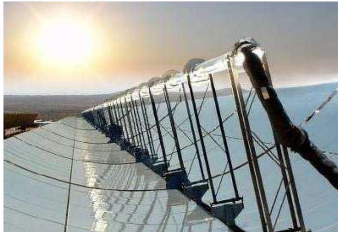
ILUSTRACIÓN 1. TUBOS ABSORBEDORES SOLDADOS.
