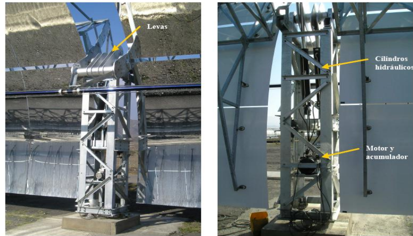
FIGURA 25. VISTAS FRONTAL Y TRASERA DE UNA UNIDAD DE SEGUIMIENTO SOLAR.
