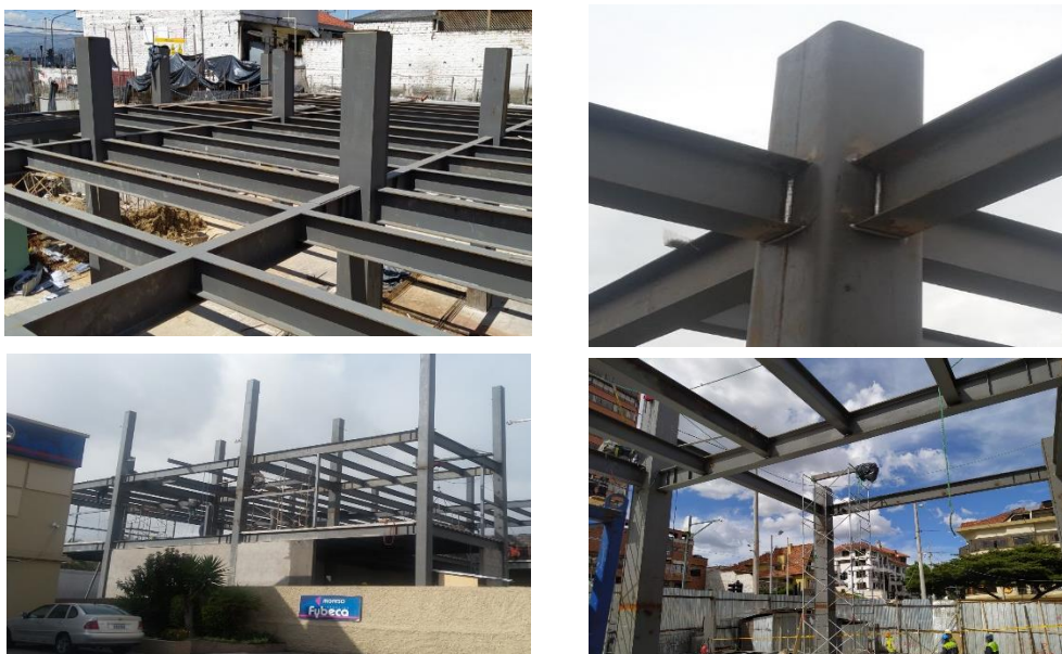
Figura 34. Conexiones Usadas en el Medio
