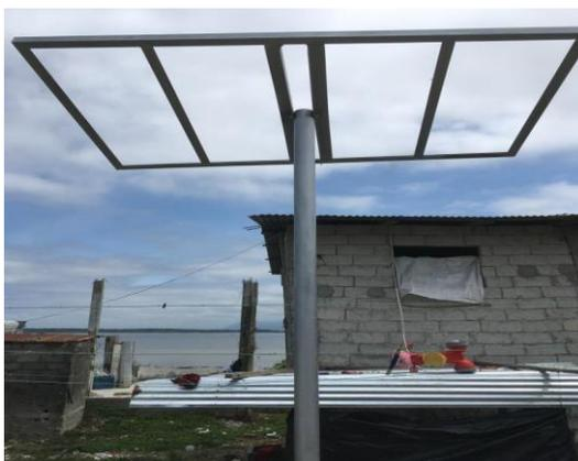
Ilustración 57 - Estructura fotovoltaica terminadas de pintar
