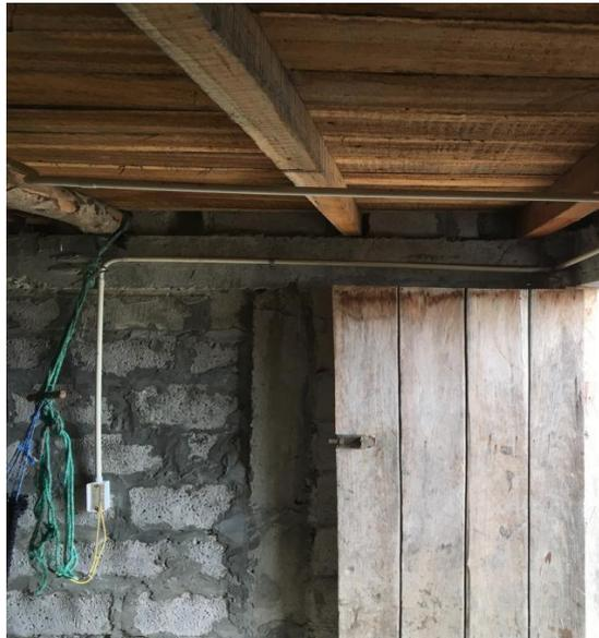
Ilustración 43 - Cableado eléctrico para circuito de tomacorrientes
