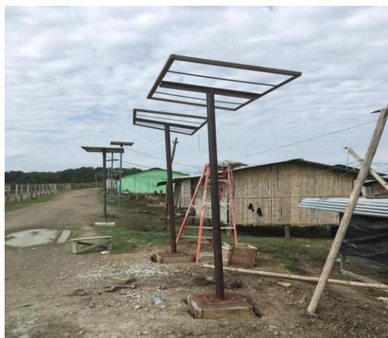
Ilustración 56 - Estructuras fotovoltaicas listas para pintar
