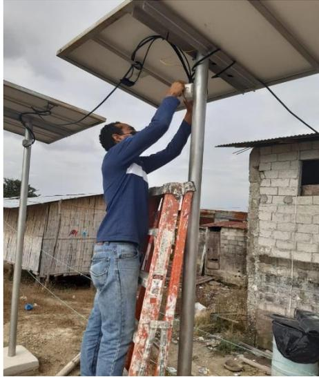
Ilustración 61 - Conexión en serie de los paneles solares
