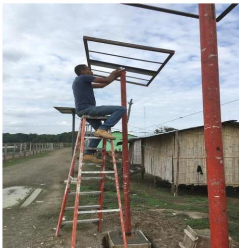
Ilustración 55 - Orientación del campo FV a una inclinación de  $10^\circ$
