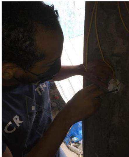
Ilustración 46 - Instalación de interruptores
