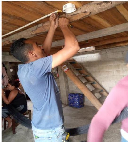
Ilustración 44 - Cableado Eléctrico para circuito de luminaria
