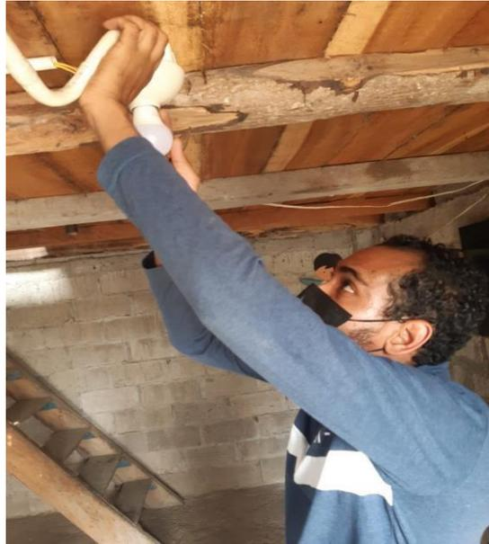
Ilustración 45 - Colocación de las boquillas y foco de las luminarias
