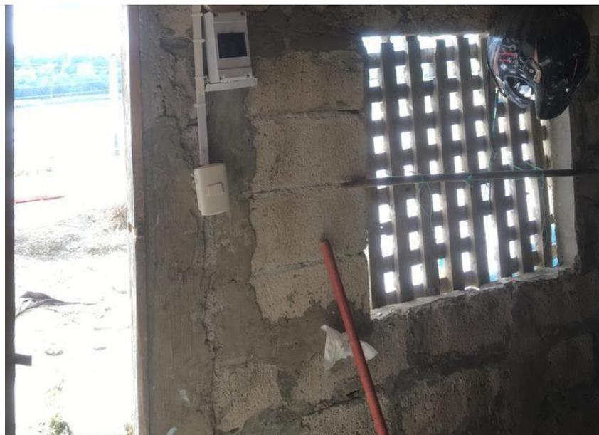
Ilustración 41 - Panel de disyuntores instalado
