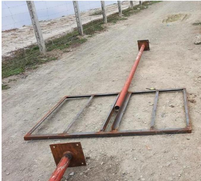
Ilustración 51 - Tubo y base para armar la estructura metálica
