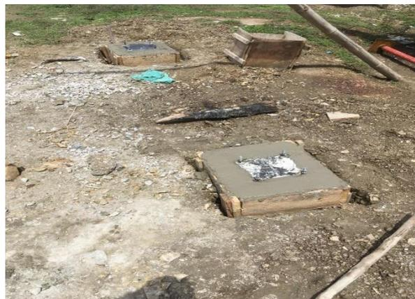
Ilustración 50 - Base de concretos fundidas
