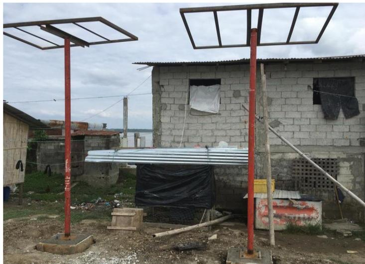
Ilustración 54 - Estructuras metálicas fotovoltaicas sobres las bases de concreto
