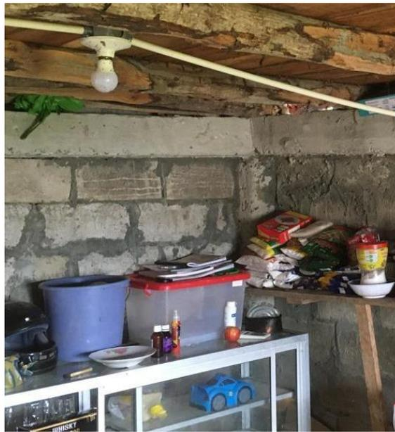
Ilustración 42 - Instalación de tubos donde pasan los cables para los circuitos
