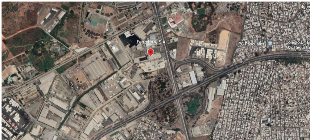
Fig. 1 Vista de la Empresa Ferro Torre S.A.
