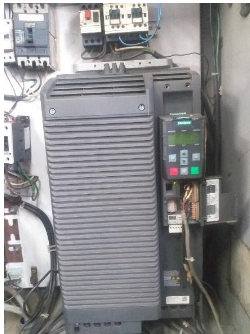
Fig. 6 Variador para motor de perfiladora
