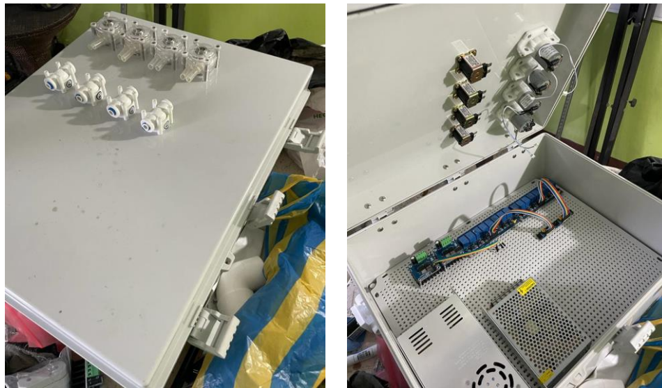
Figura 16: Montaje del tablero de la planta
