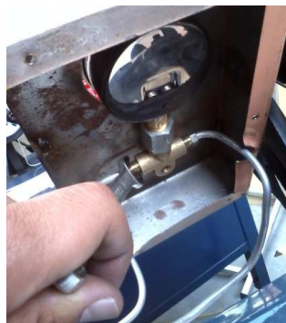
Figura 3.12 Instalación de cañerías. Fuente: Los Autores
