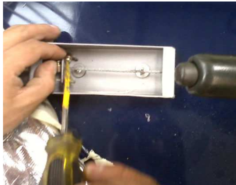
Figura 3.18 Instalación de los cables. Fuente: Los Autores
