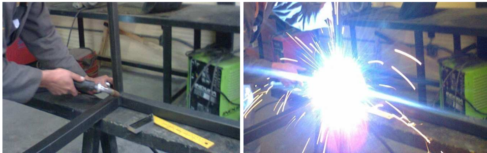
Figura 2.16 Tubos que servirán para los soportes.
