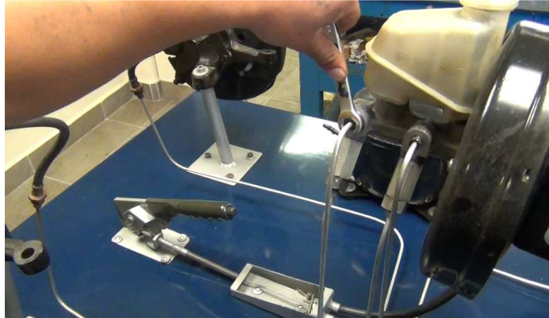
Figura 4.76 Colocación de neplros de las cañerías. Fuente: Los Autores
