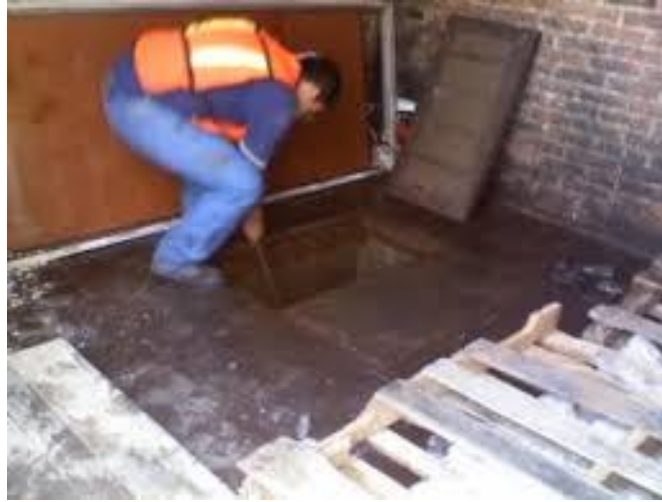
Figura 4. Limpieza de la trampa de grasas.
