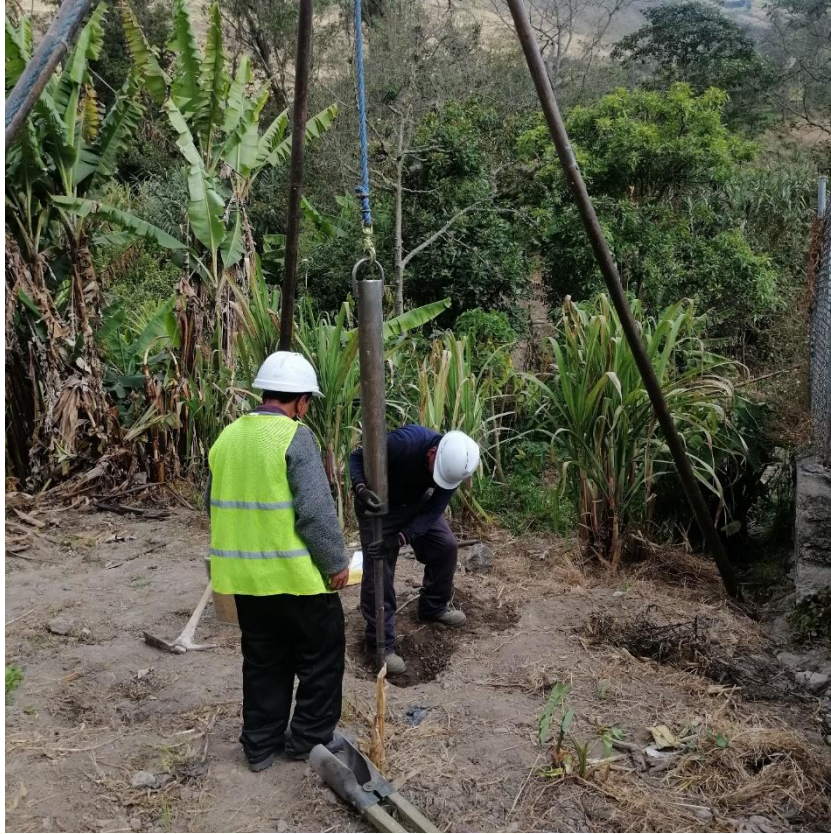
Fotografía 5.- Realizando el ensayo de SPT para ver la capacidad portante del suelo.
