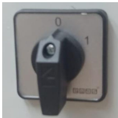
Figura 27. Selector eléctrico EMAS 2 posiciones
