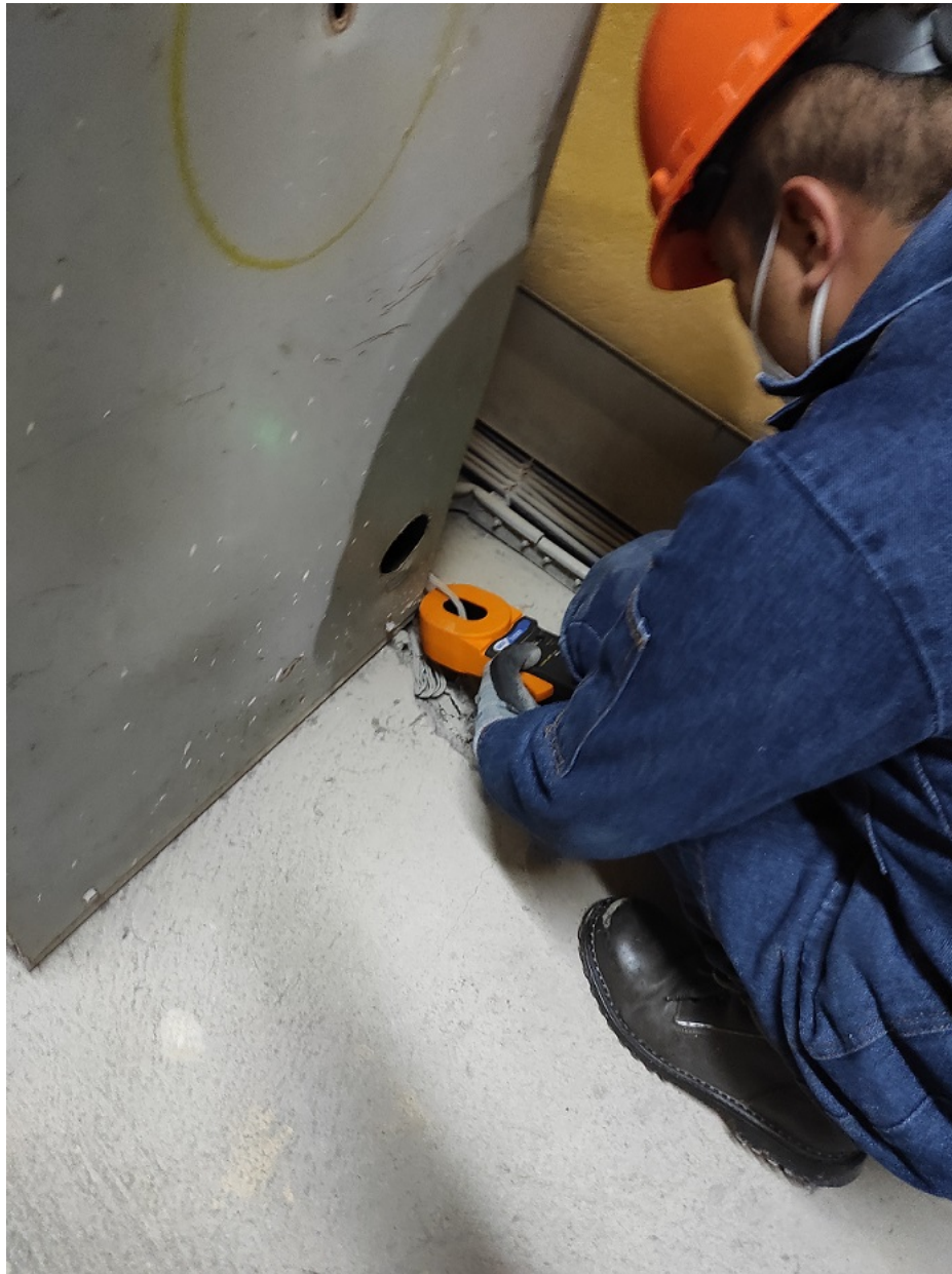
Figura 7.11: Medición de resistencia de malla puesta a tierra en derivación a transformador
