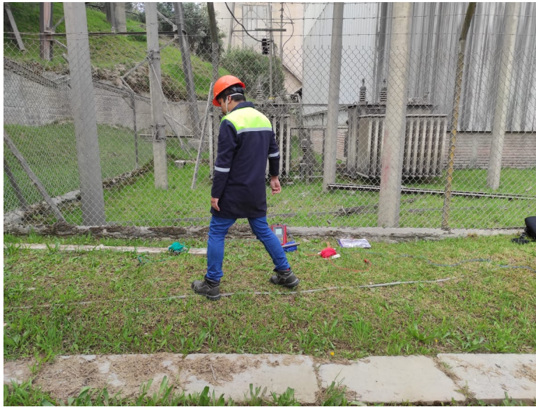
Figura 7.2: Medición 2 de la resistividad del terreno en la subestación M1.
