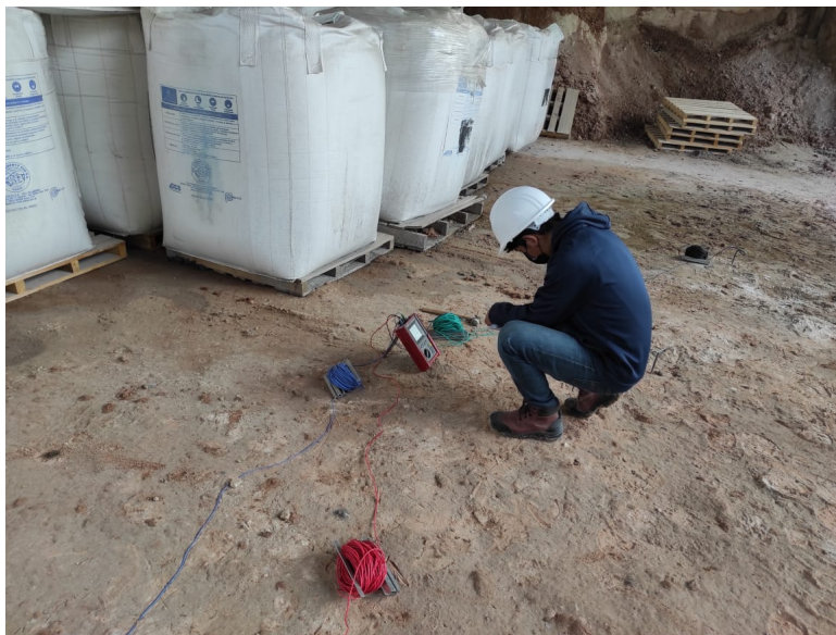
Figura 7.1: Medición 1 de la resistividad del terreno en la subestación M1
