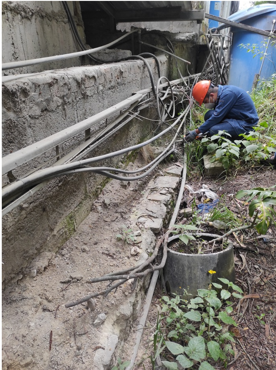
Figura 7.10: Medición de resistencia de derivación de varilla Copperweld.
