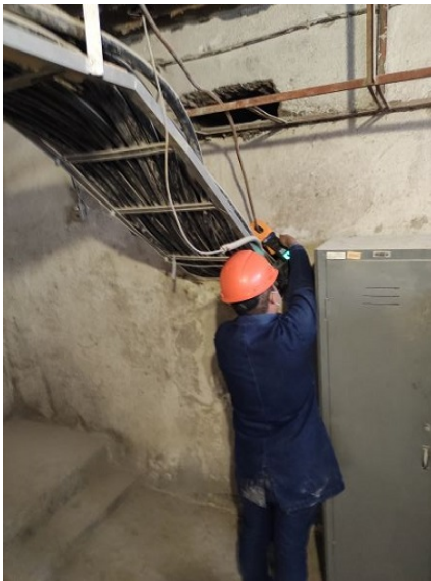
Figura 7.5: Medición de resistencia de malla puesta a tierra en derivación a canastillas de conductores eléctricos
