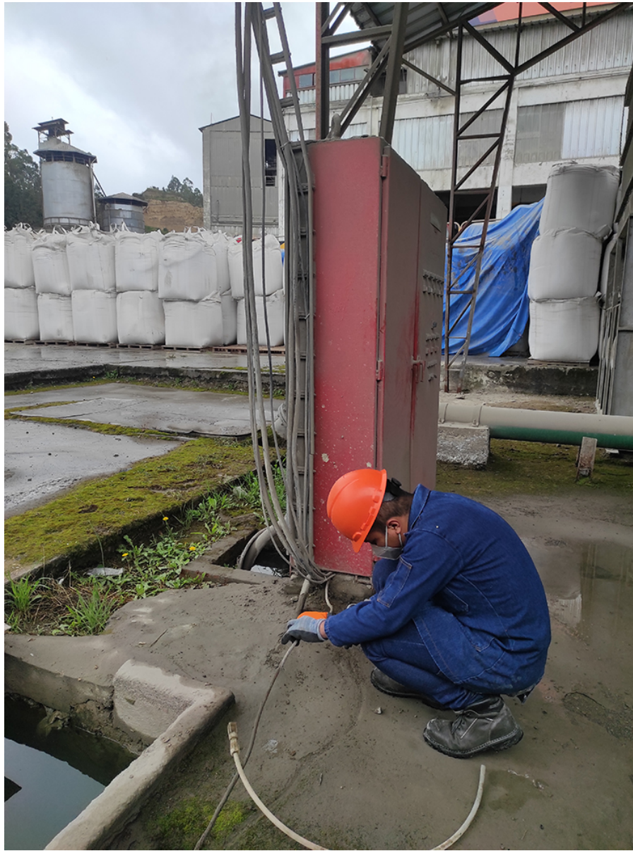
Figura 7.12: Medición de resistencia de malla puesta a tierra en derivación a motores de bombas de agua.
