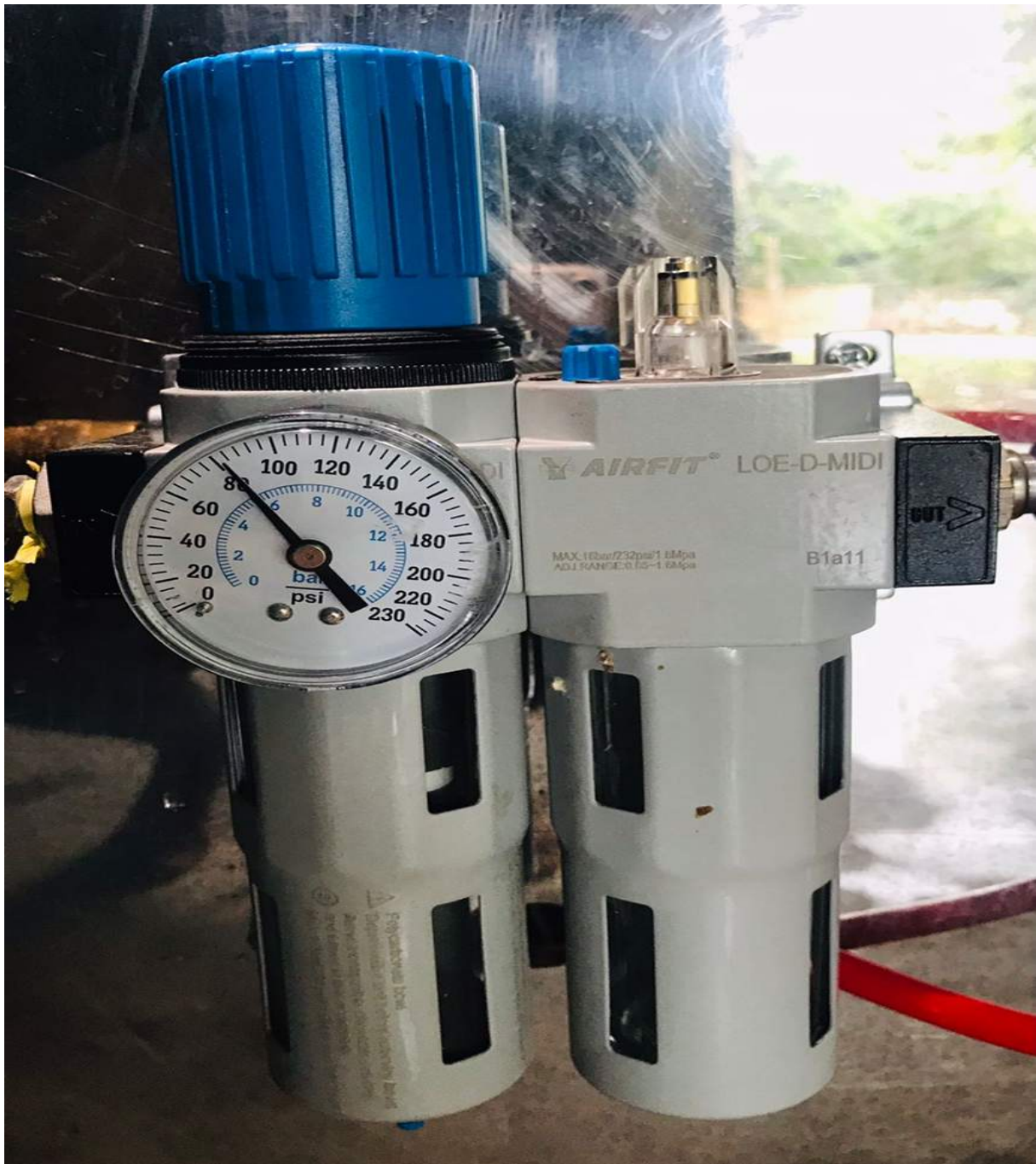
Figura 61. Instalación de la unidad de mantenimiento.
