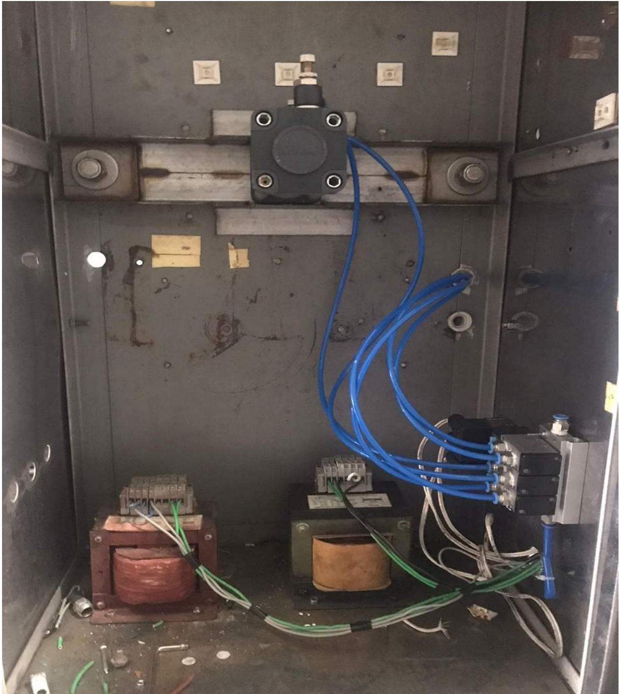
Figura 56. Instalación de la electroválvulas y mangueras.
