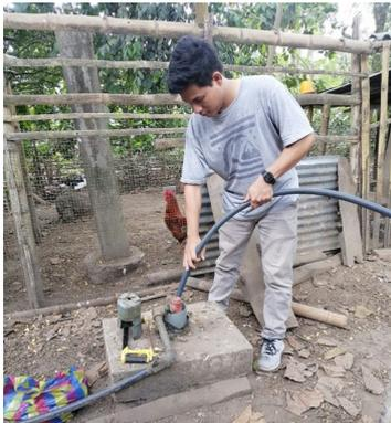
Para la colocación de los aspersores se utilizó una tubería PE de 1/2 pulgada la cual contara con 3 aspersores con una distancia de 10 metros entre sí, cabe aclarar que esta configuración se realizó en las dos zonas de trabajo. En la “Figura 84” se presenta la ubicación de los aspersores y la tubería secundaria y terciaria.
