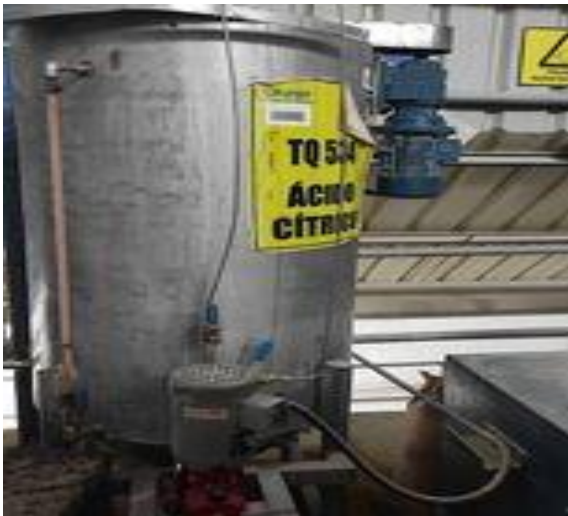
Foto 13: Tanque de ácido cítrico
