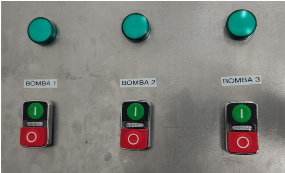
Figura 9. Botoneras y luces piloto para operar en "LOCAL" (Autor)
