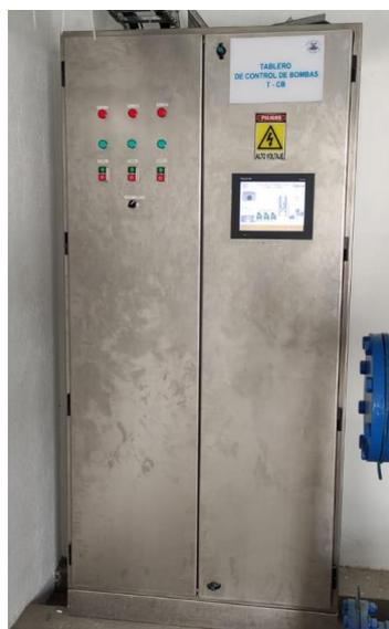
Figura 10. HMI para operar en "REMOTO" (Autor)
