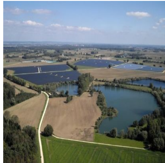
(b) Planta fotovoltaica conectada a la red con una generación de 25,7 MWp .
