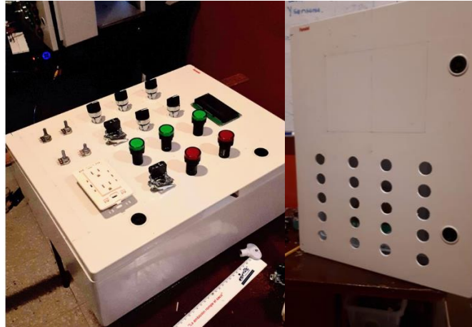
Figura 33: Perforación de puerta para elementos
