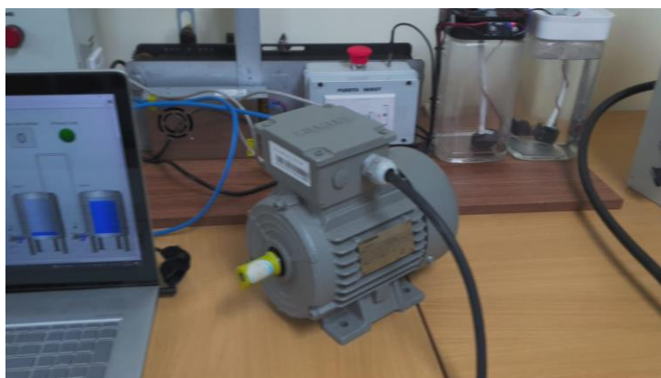
Figura 67: Motor trifásico en funcionamiento.
