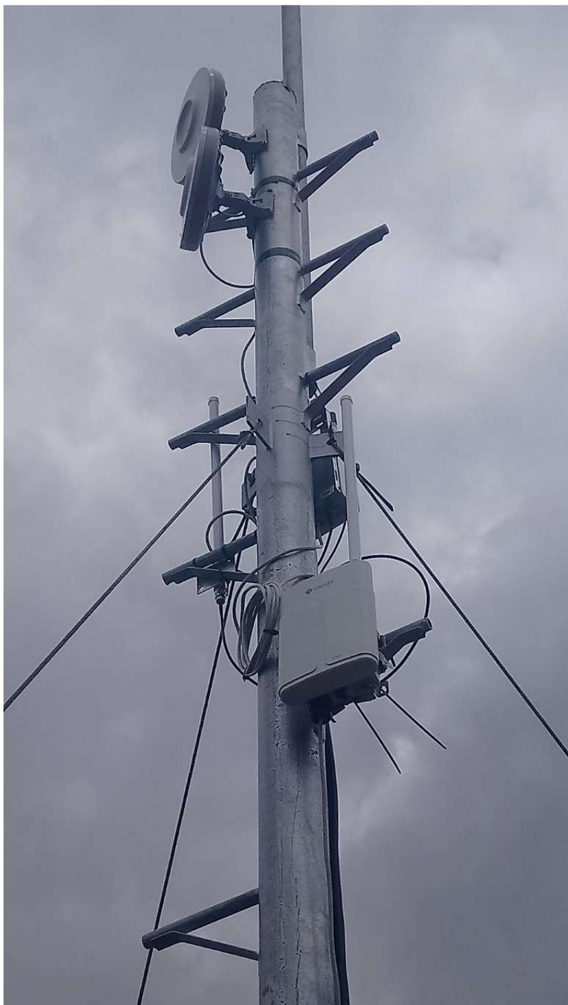
Figura 2.54: Gateway Milesight UG67 ubicado en la azotea del edificio Cornelio Merchan de la UPS sede Cuenca [fuente: el autor].
