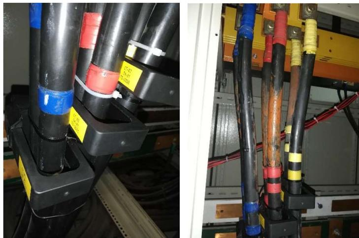
**Figura 79. Instalación TC núcleo partido 4 circuitos GE-TR-02**
