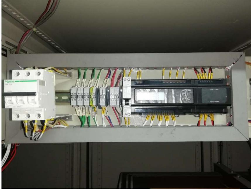
**Figura 78. Analizador de red múltiple instalado**
