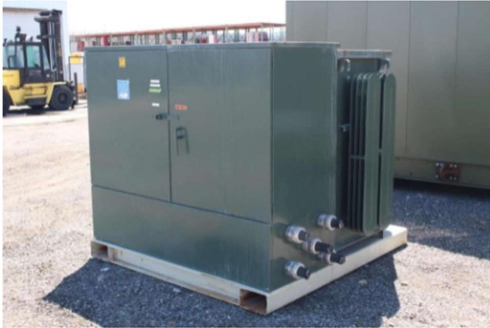
**Figura 39. Transformador tipo Padmounted**
