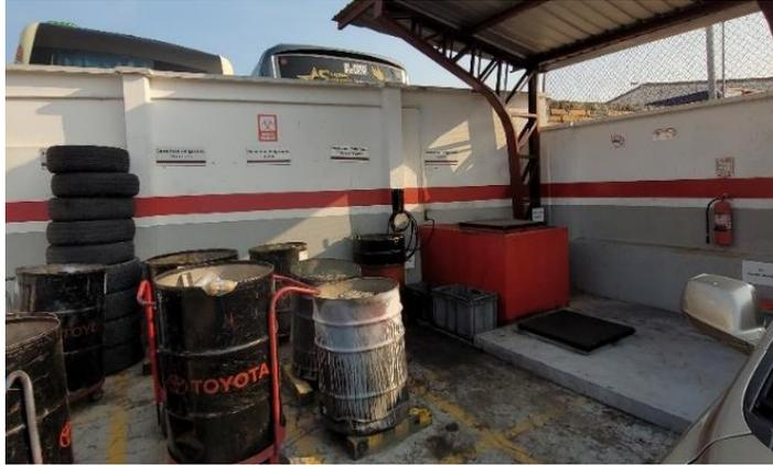
*Ilustración 34 Almacenamiento y despacho de aceites usados y materiales contaminantes.
