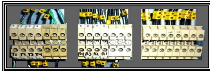
**Figura 4.30.** Borneras de conexión para inyectores y termistores
