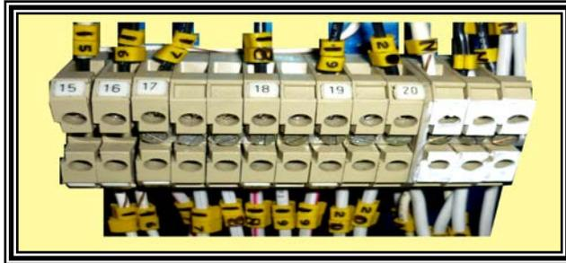
**Figura 4.32.** Borneras de conexión para válvulas.
