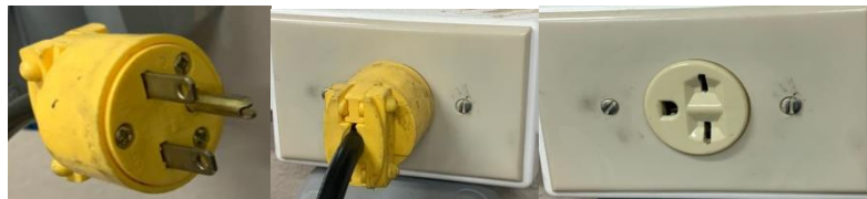
Ilustración 5: Conexión de tomacorriente 220V
