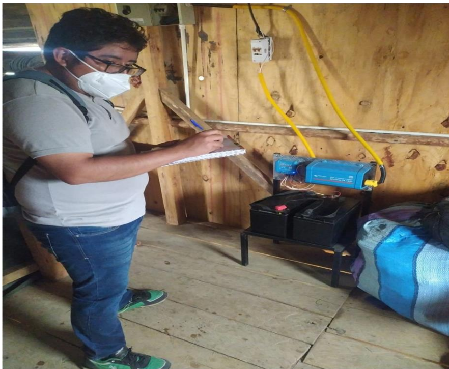
Figura 56. Comprobación del sistema fotovoltaico aislado.
