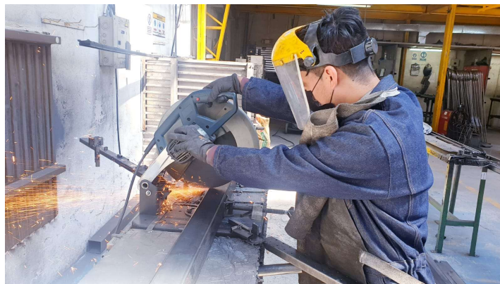
Figura 32. Corte de perfiles estructurales con tronadora
