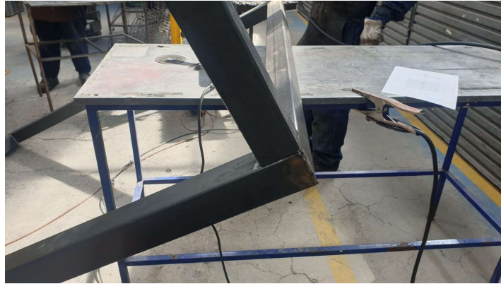
Figura 35. Proceso de encuadre de perfiles rectangulares para soporte de estructura
