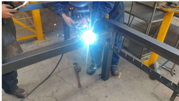
Figura 36. Proceso de encuadre de perfiles rectangulares para soporte de estructura
