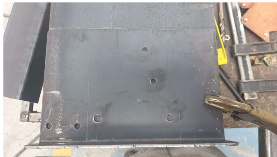
Figura 45. Proceso de perforación platina de cabezal eje Z.
