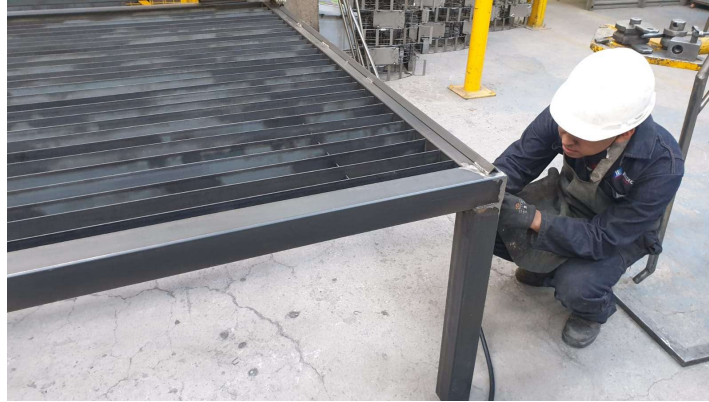
Figura 37. Proceso de encuadre de perfiles rectangulares para soporte de estructura
