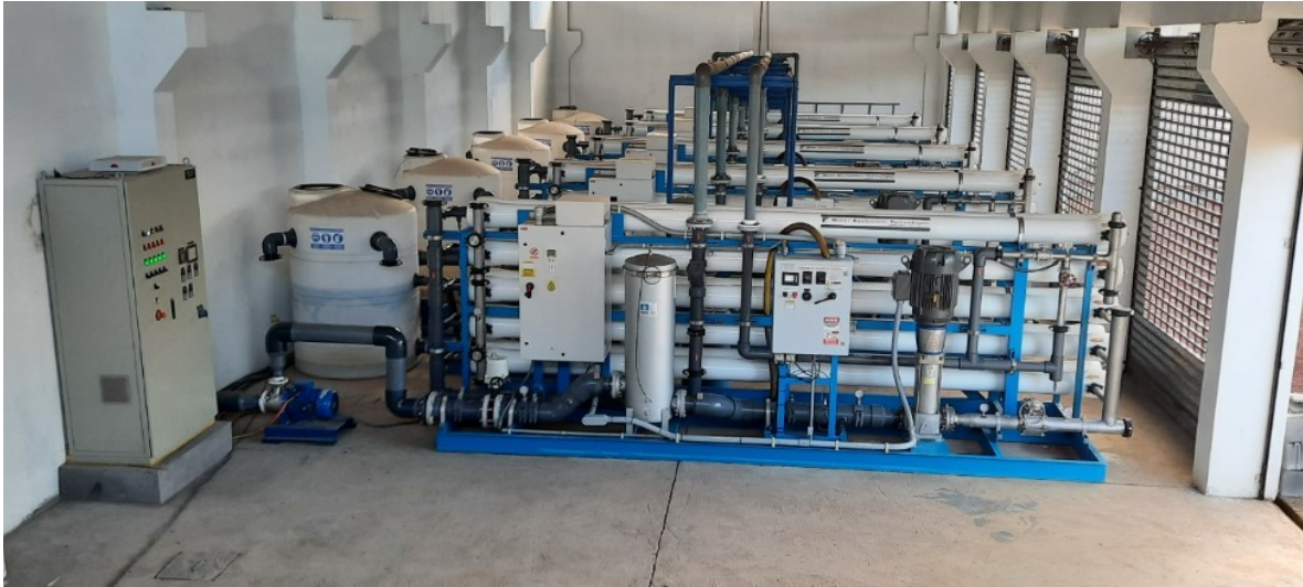
Anexo 3 Planta desalinizadora por Osmosis Inversa de 43 metros cúbico/hora a partir de agua salobre
