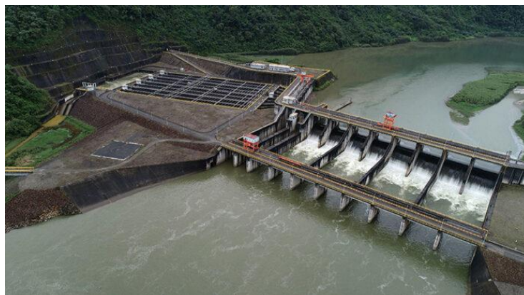
Figura 3. Central hidroeléctrica Coca Codo Sinclair [19].
