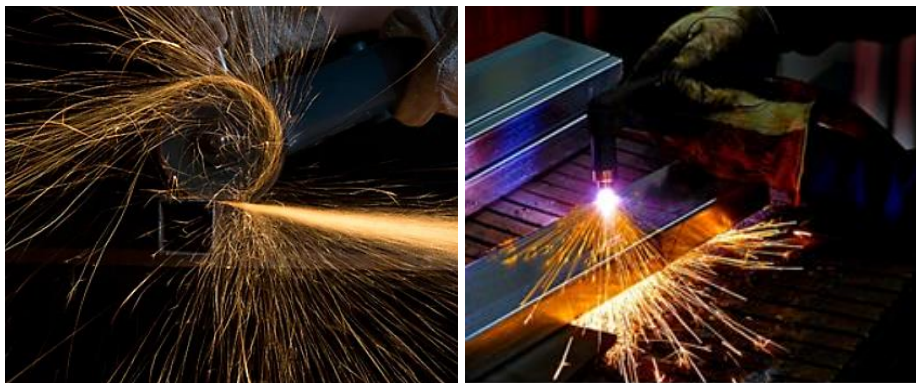
Figura 3.1. Corte y soldadura de la estructura metálica
