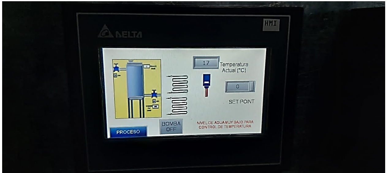
Figura 66. Control de temperatura
