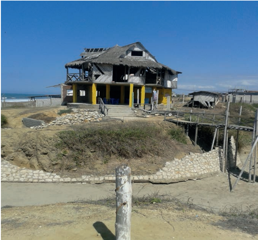
Figura 4. Deteriorado estado constructivo de las instalaciones de servicios turísticos
