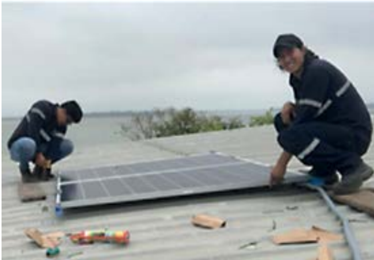
Figura 8 Instalación de los paneles fotovoltaicos
