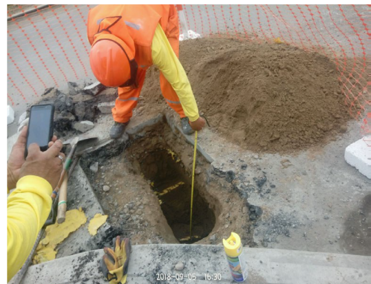
Figura 1. Construcción, demolición y excavación de zanjas [8]
