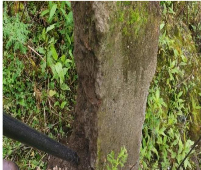
Para el análisis y modelamiento del muro en mampostería se tomó un estimado de su geometría, altura de 2,50m con una base en la zapata de 1,20m.
