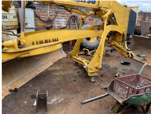
Imagen 121. Reparación gatos hidráulicos
