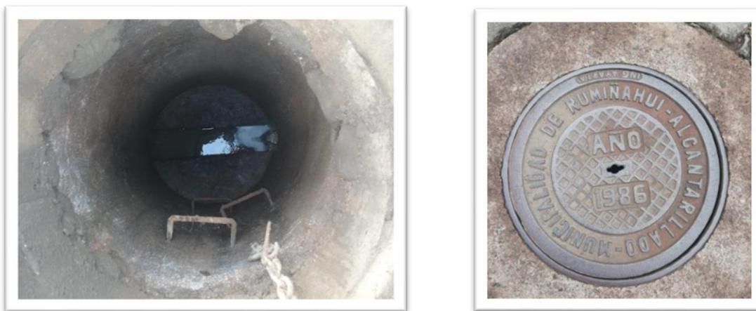
*Nota.* Fotografía de pozo de alcantarillado sanitario y tapa de hierro fundido. Elaborado por: Los autores.
