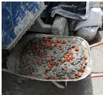
Figura 7. Incorporación manual del ladrillo triturado.
