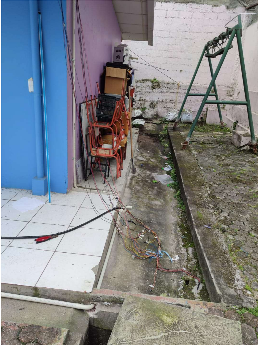
Figura 57. Pruebas empatando cable viajero
