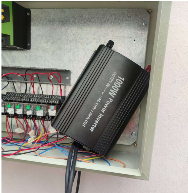
Figura 59. Inversor quemado
