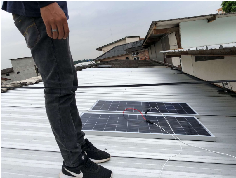
Figura 40. Colocación de paneles solares
