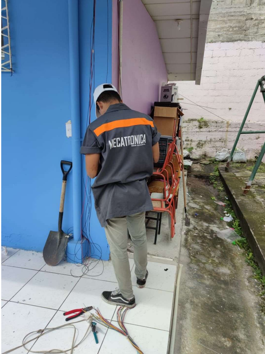
Figura 56. Empatando cable viajero
