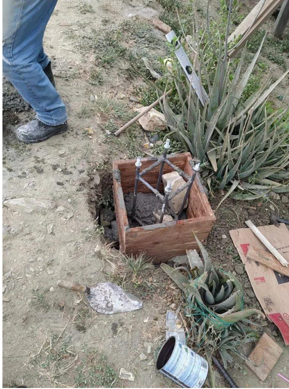
Imagen 45. Base de concreto
