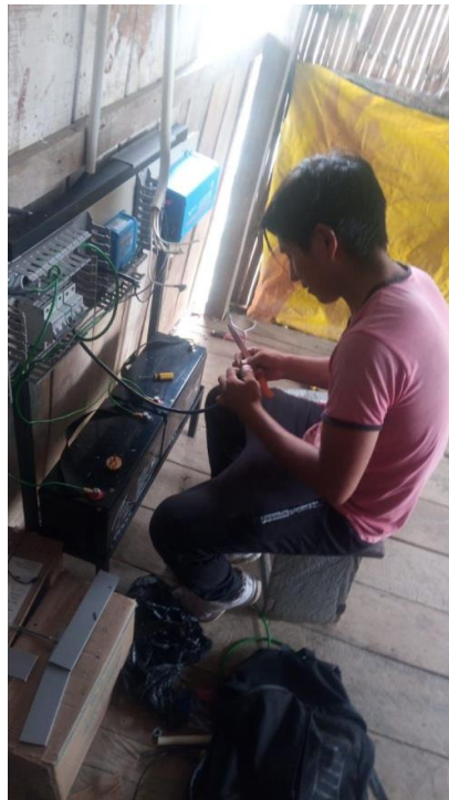
Imagen 47. Base metálica usada para la colocación de equipos
