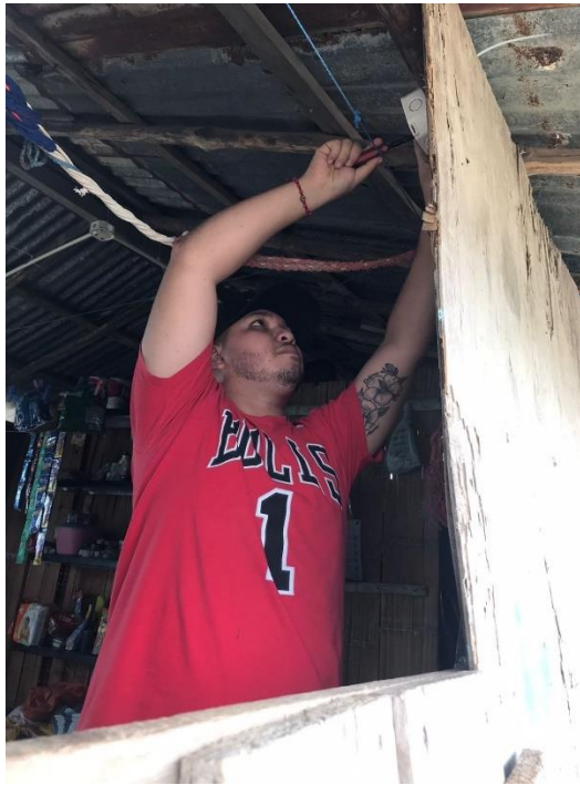
Imagen 41. Instalación de los tubos PVC
