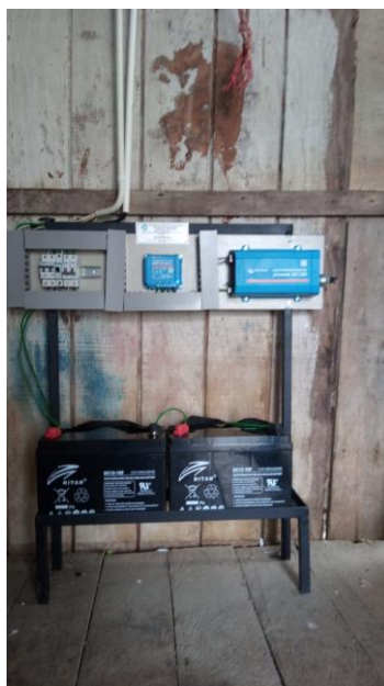
Imagen 49. – Colocación de elementos fotovoltaicos
