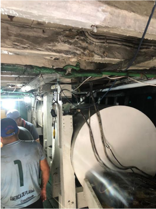
Mal estado de las instalaciones y del cableado
