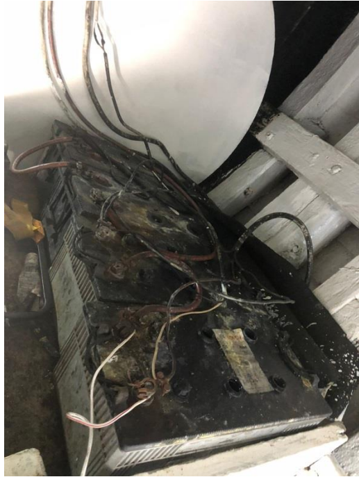
Mal estado de las instalaciones y del cableado
