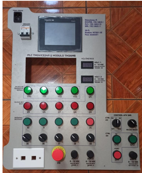
Figura 47. Montaje de Elementos en el plafón superior
