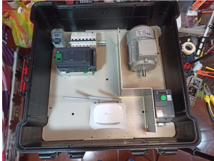
Figura 45. Montaje de equipos en el plafón inferior
