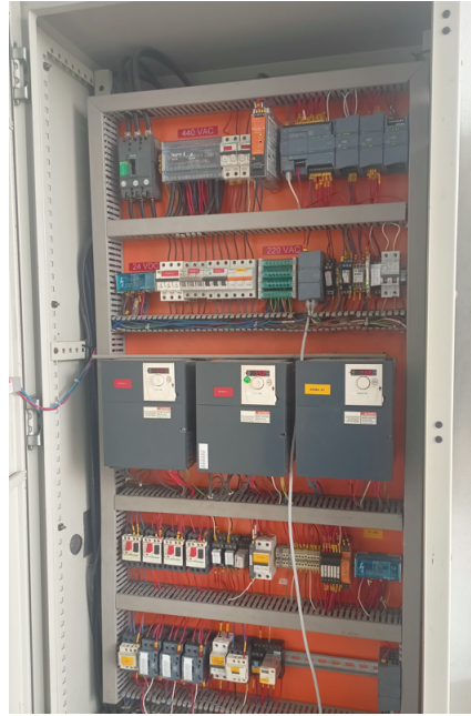
Figura 3.5: Pantallas sistema de bombeo.
