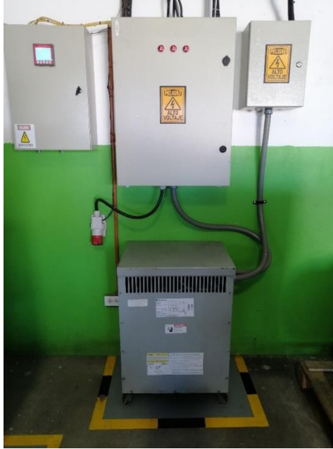
Figura 26 Demarcación áreas peligrosas.
