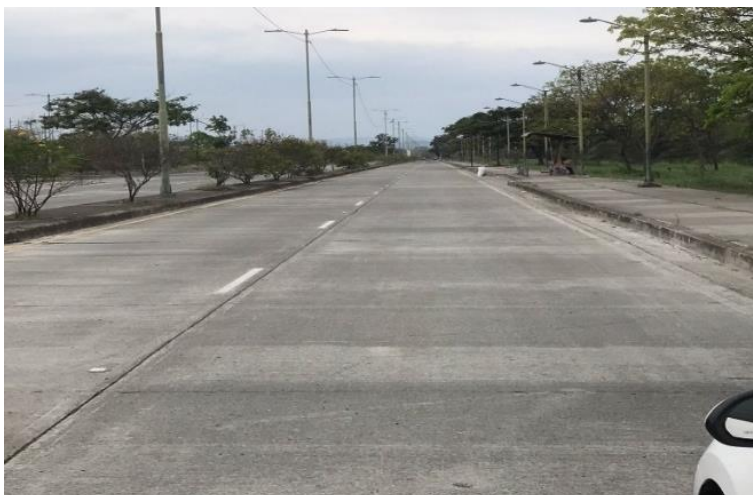
Figura 21. Vía para la prueba de ruta con superficie de Hormigón. Fuente: Autores
