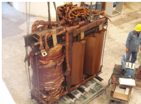
Figura 1-10. Mantenimiento de un devanado destruido en un transformador de potencia.
