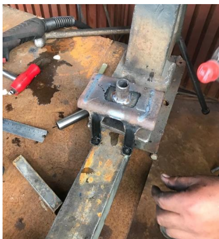
Figura (4-18). Soldadura eje motor
