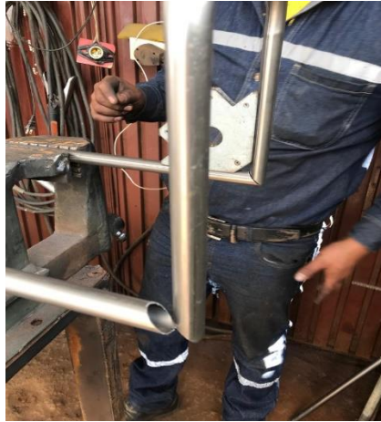
Figura (4-16). Soldadura puntos estructura de mochila
