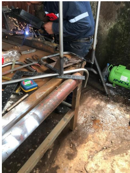
Figura (4-17). Soldadura base motor
