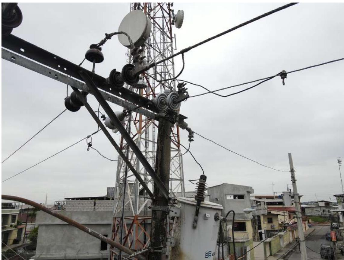
**Diagnóstico en seccionamiento, nivel de voltaje 13.8 kV**
