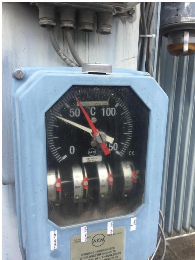
*Figura 3. 12: Revisión de termómetro AKM de Transformador de Potencia Trifásico.*
