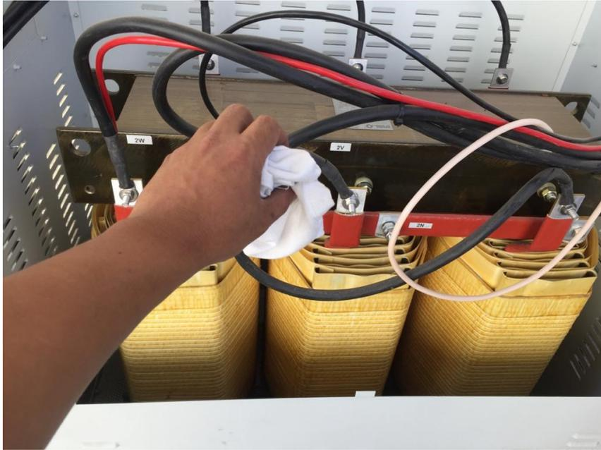
*Figura 3. 11: Revisión de terminales de alta tensión.*
