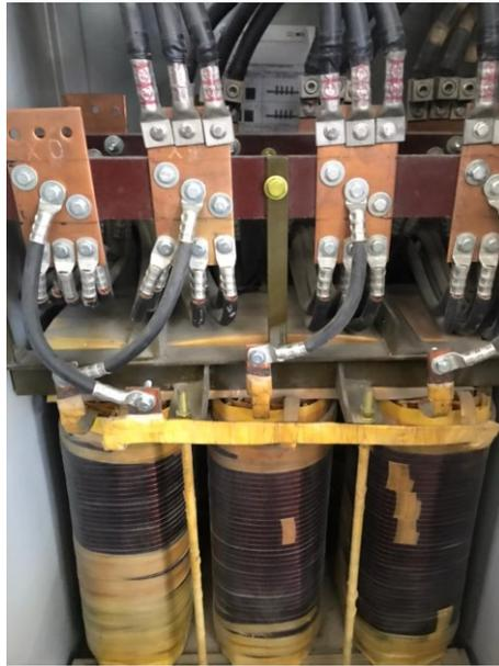
*Figura 1. 12: Interior de un autotransformador de tres devanados de 700 kVA [10].*
