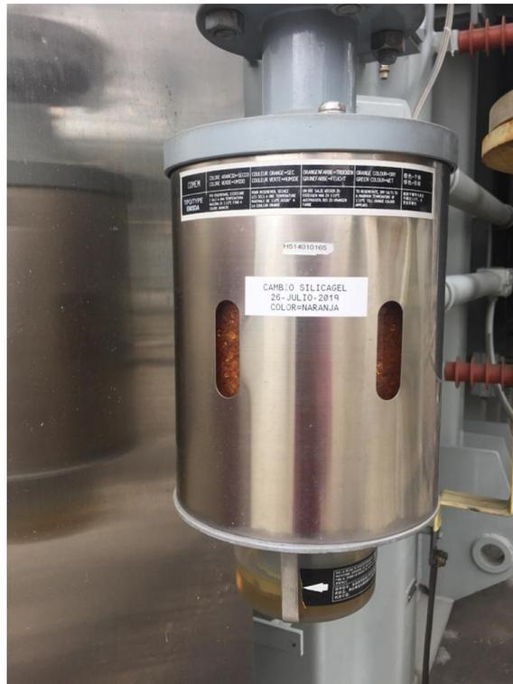
*Figura 3. 15: Inspección del estado del recipiente de Respiradores de gel de sílice.*
