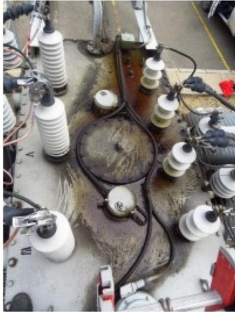
*Figura 2. 1: Filtraciones de aceite en un transformador de potencia [19].*
