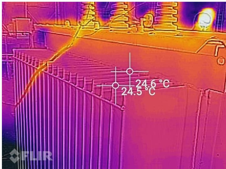
Figura 2.5. Visión termográfica de un transformador trifásico de potencia. Autor.
