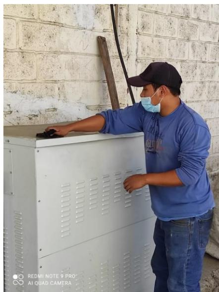
Figura 3. 3: Limpieza de la carcasa exterior de un transformador trifásico de potencia EREMU.SA
