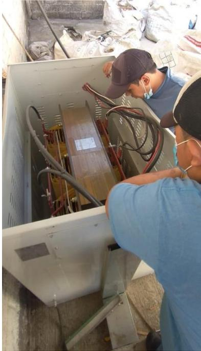
*Figura 3. 8: Revisión de ruidos emitidos por el transformador trifásico de potencia.*
