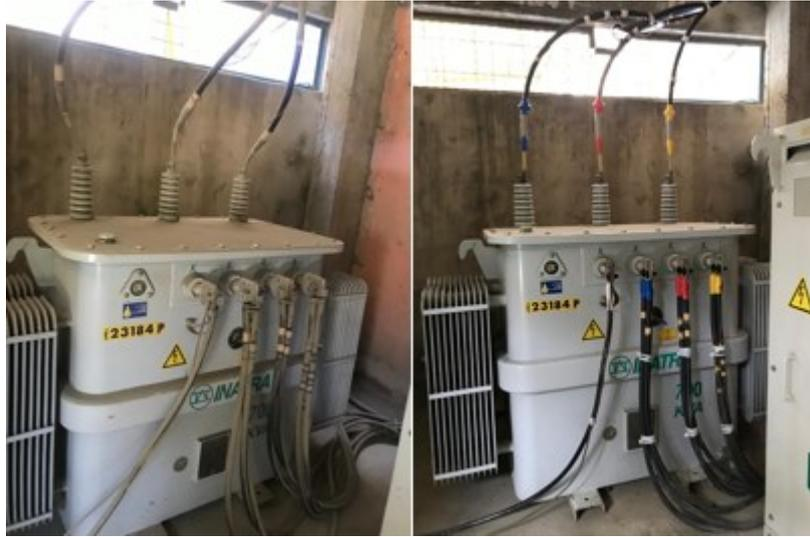
*Figura 3. 4: Antes y después de limpieza de la carcasa y accesorios exteriores de transformador.*
