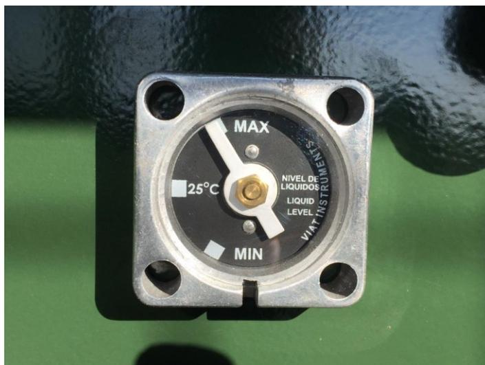
*Figura 3. 13: Inspección del nivel de aceite del medidor de presión de aceite Transformador de potencia trifásico ECUATRAN 13.8/440V.*
