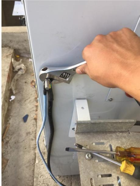
*Figura 3. 9: Reajuste de terminal de toma de puesta a tierra del transformador.*
