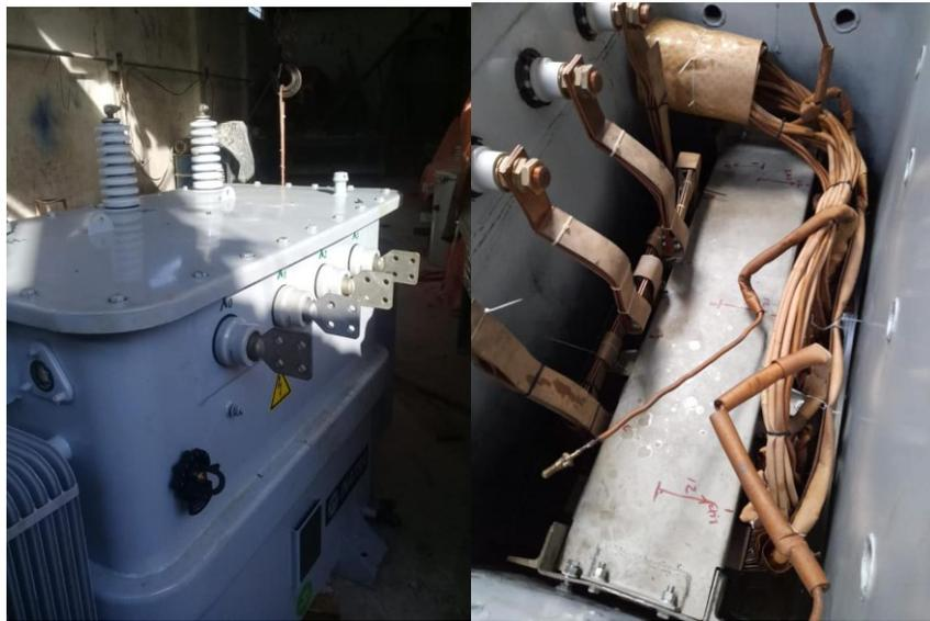
*Figura 4. 14. Posicionamiento del tap de 7 posiciones en el transformador trifásico de 0,8 MVA*
