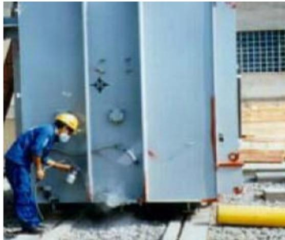
*Figura 3. 20. Limpieza y retoques de pintura [24].*
