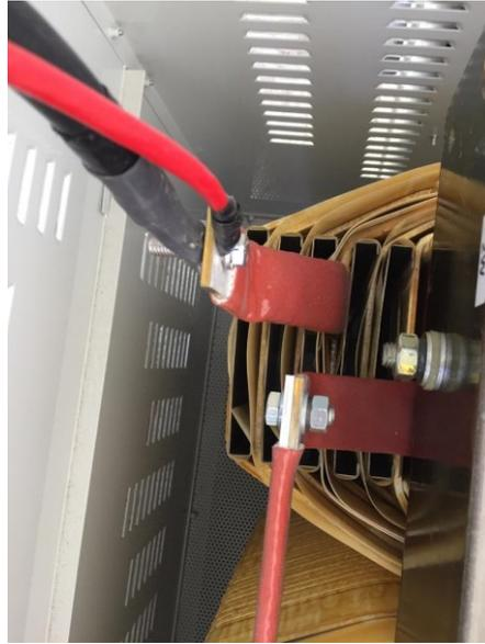
*Figura 3. 5: Revisión de ajustes de los terminales del devanado primario.*
