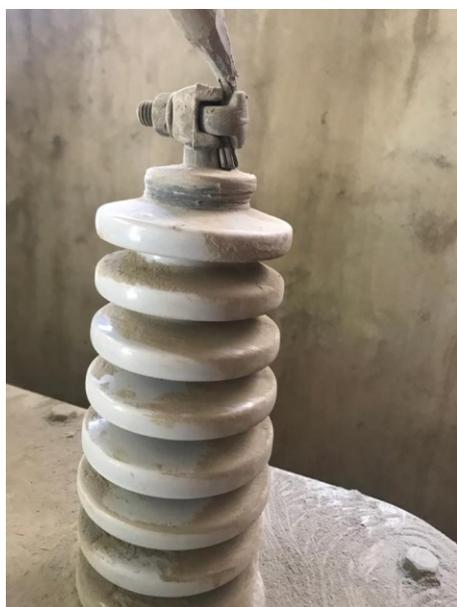
*Figura 3. 10: Inspección de bushings en transformador de 700 kVA.*
