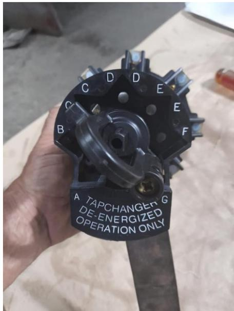
*Figura 4. 16. Intercambiador de Tap reemplazado.*
