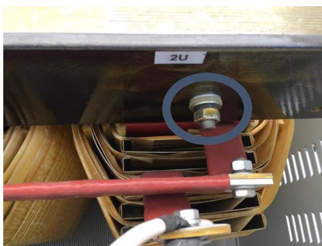
*Figura 4. 19. Pernos pasantes que sujetan la parte superior de las chapas del núcleo.*
