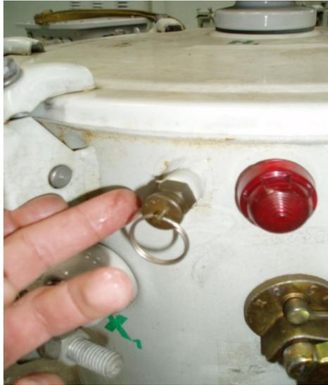
*Figura 3. 14: Válvula de sobrepresión accionada por sobrecarga del transformador.*
