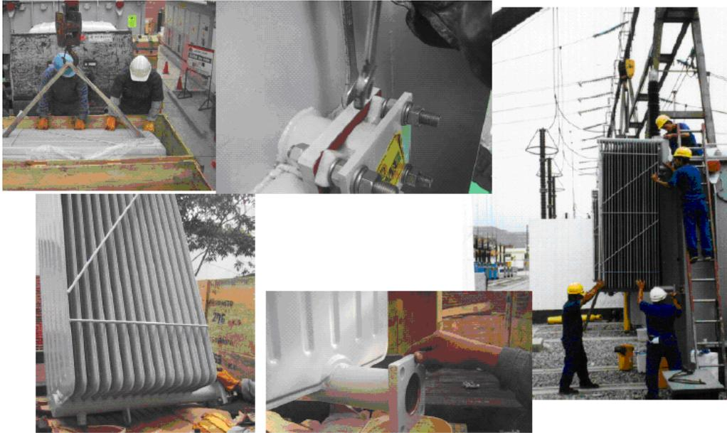
*Figura 3.21. Montaje de Radiadores [24].*
