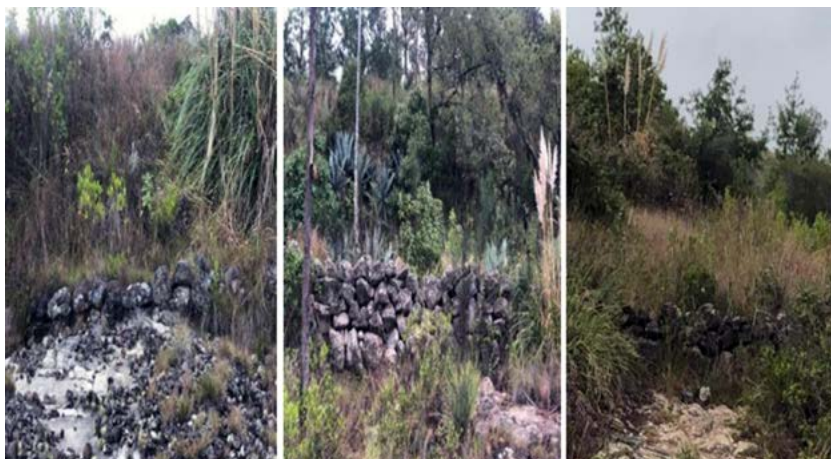
Figura 12. Muros en el sector El Plateado
