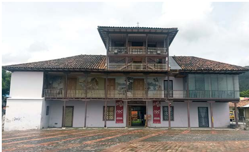
Grafico 9. Fachada de la Casa Patrimonial de Chaguarchimbana Fuente: Diario el Mercurio de Cuenca
