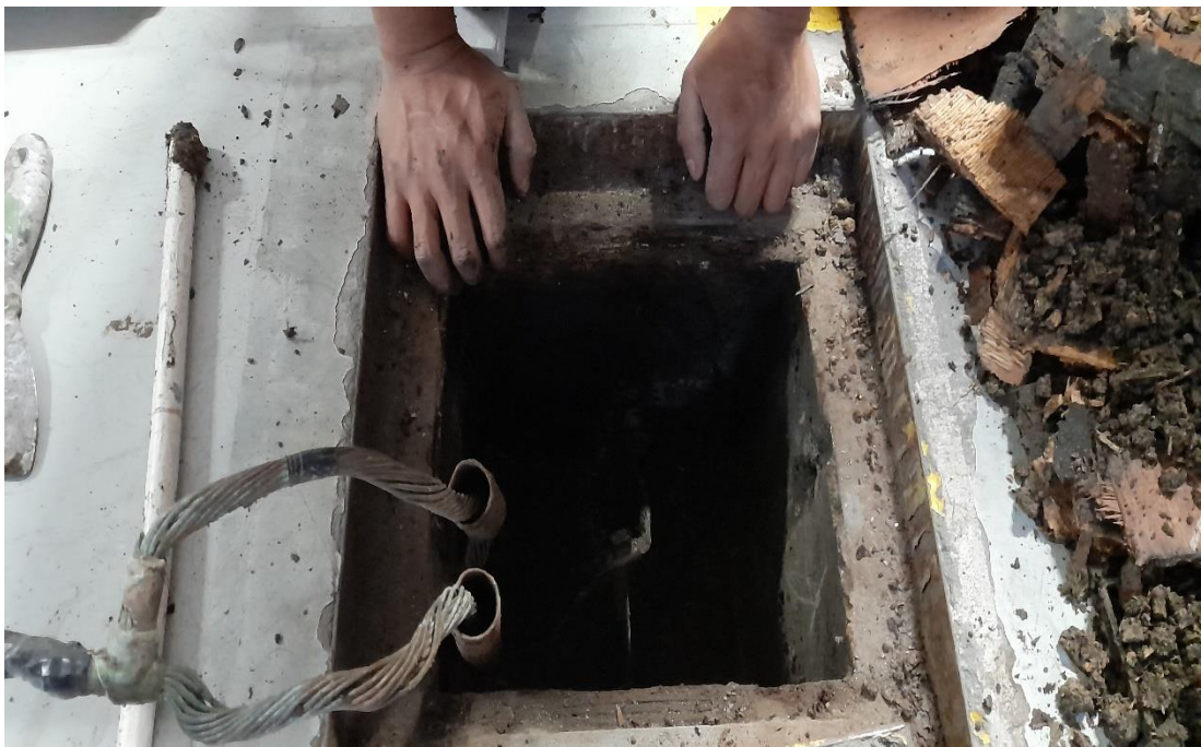
Figura 27. Limpieza de los pozos de revisión de las mallas.
