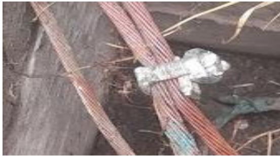
Figura 6. Conexión atornillada.
