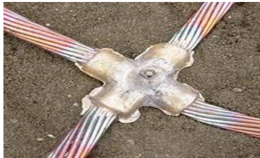
Figura 7. Conexión exotérmica [19].
