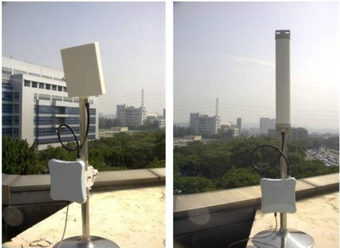
**Fig. 39 Equipos exteriores de un enlace de radio**
