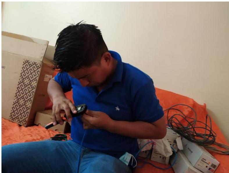
Figura 4.12 Crimpado de cables cat6
