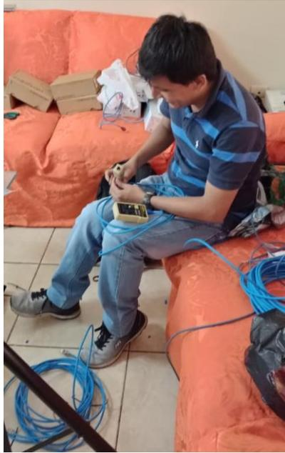
Figura 4.3 Test de prueba de cables cat 6 para pedestal 1.
